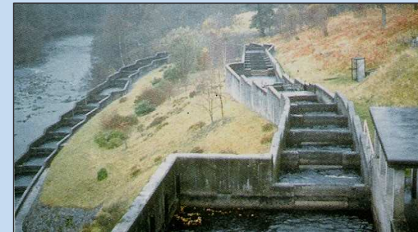
Foto 6: Scala con orifizio di fondo (Scozia).
