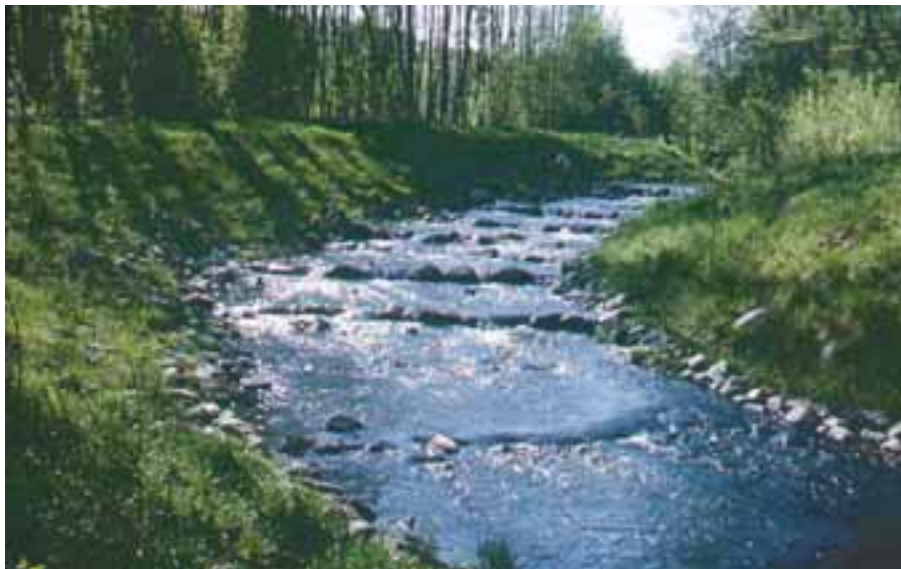
Figure 4.15: Mühlenhagen/Goldbach bottom ramp
