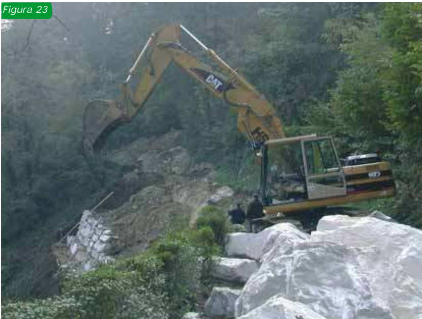
Fig.23: movimentazione di grandi massi di cava con escavatore cingolato, nella ricostruzione di un versante franato
