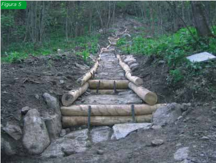
Figg.6-7-8: fasi costruttive di un breve tratto di canalizzazione in legname e pietrame, per favorire il corretto scarico delle acque in un torrente
