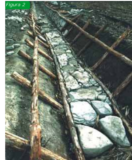
Figg.1-2-3: fasi costruttive di una canalizzazione in legname e pietrame
