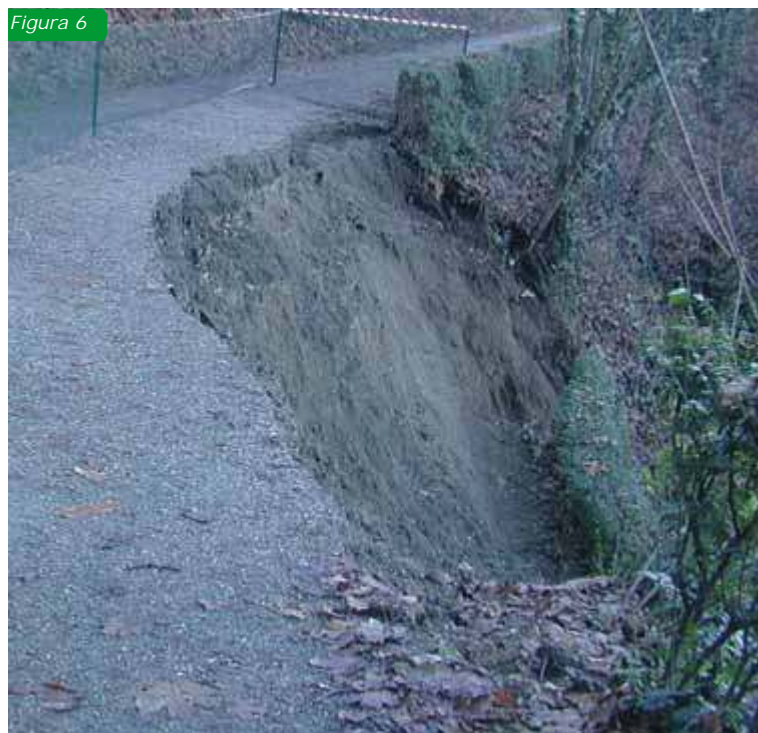
Figg.6-7-8: sistemazione di una scarpata stradale con l'allestimento di terre rinforzate e palificate, poste sopra una base in massi. L'inerbimento è stato effettuato con idrosemina su rete in fibra naturale di juta.
