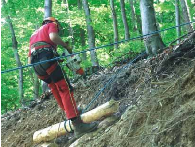
Foratura delle travi della grata
