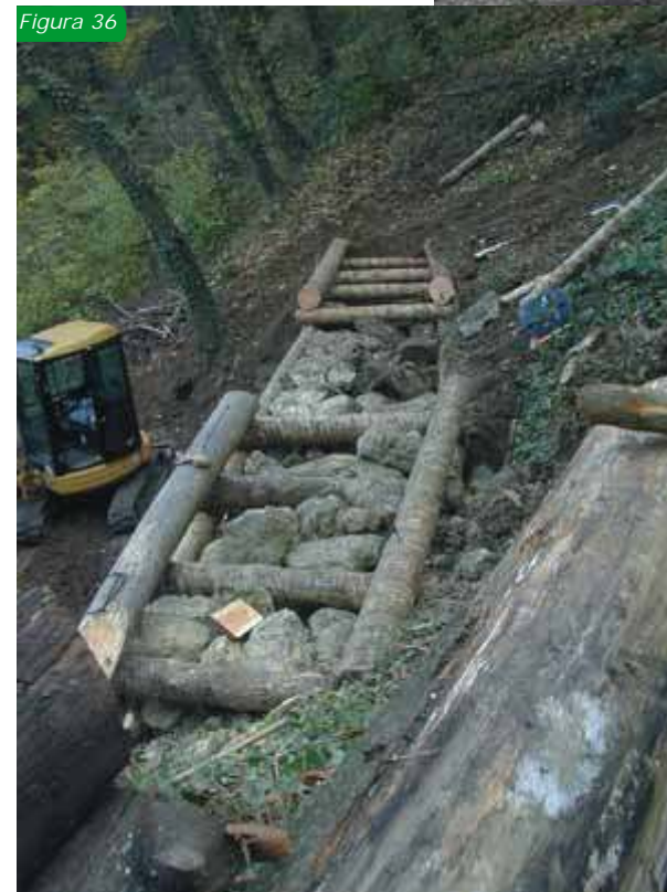
Fig. 36: riempimento della briglia con pietrame di pezzatura grossolana
