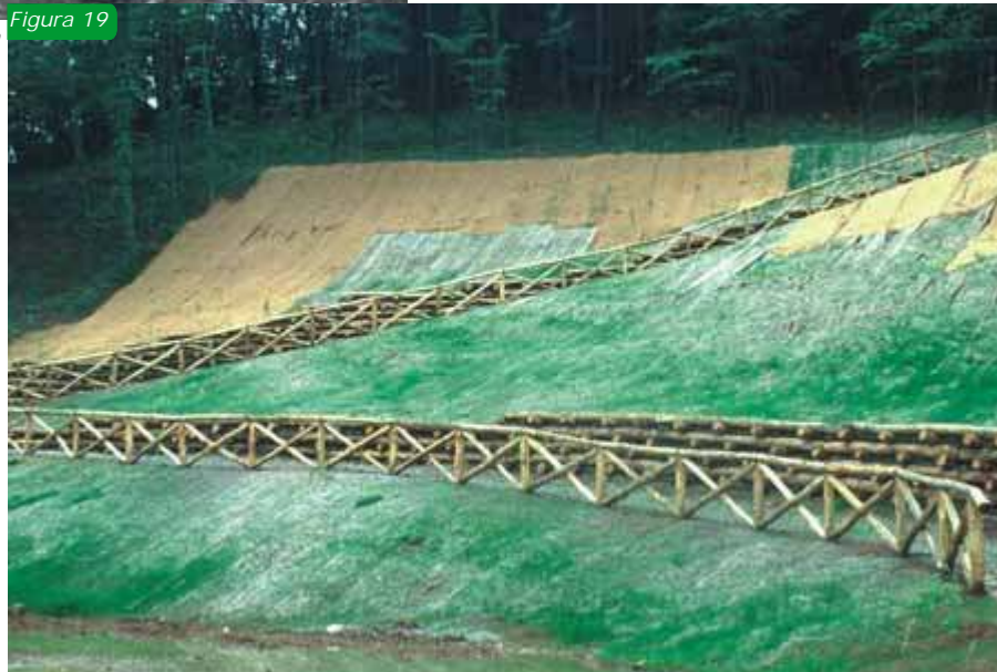
Fig. 19: reti in fibra naturale di cocco (non ancora inerbite)
