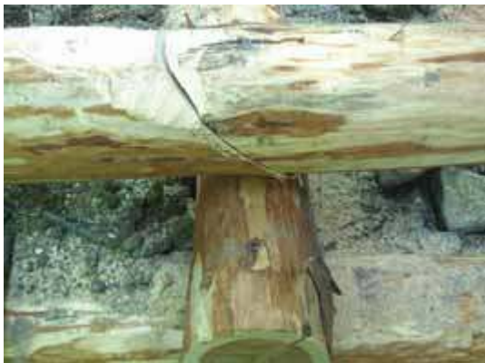
INCASTRO MEDIANTE TAGLIO OBLIQUO
