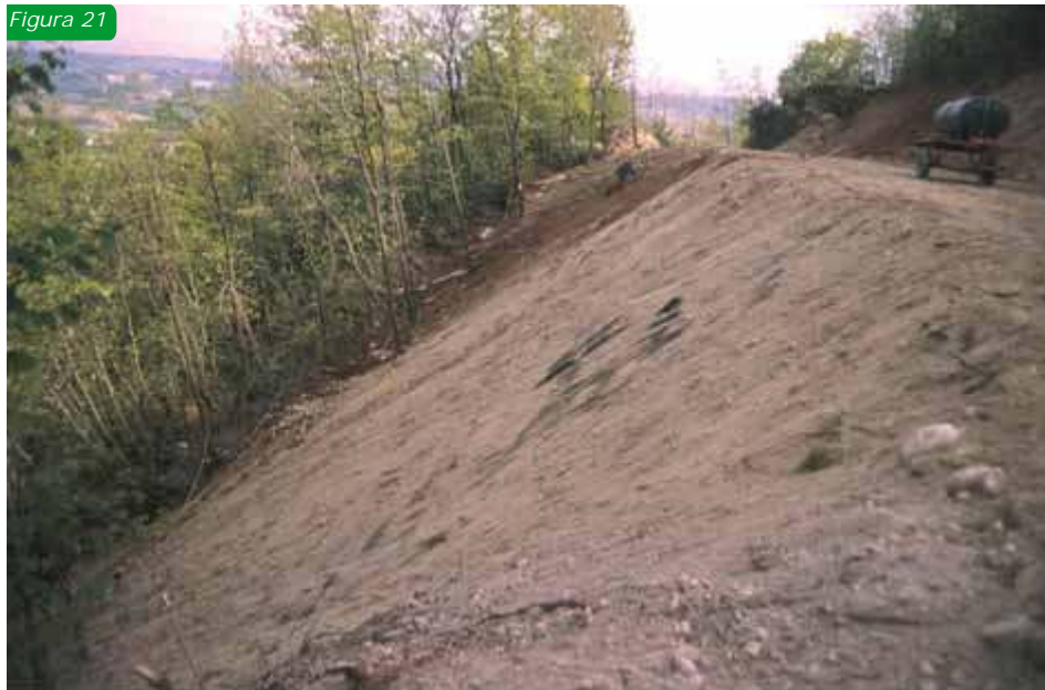
Figg. 20-21-22: geostuoia tridimensionale e suo impiego nella rinaturalizzazione di un versante
