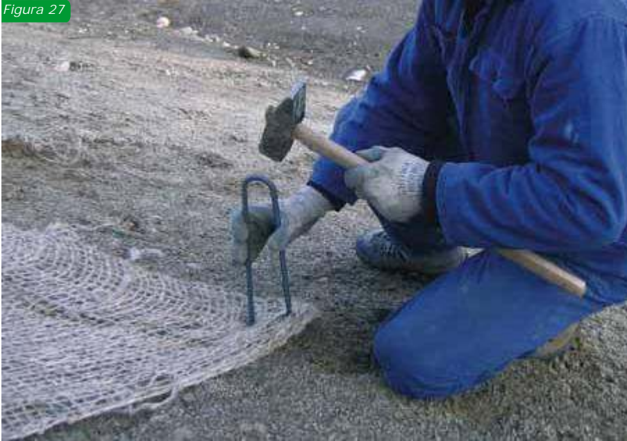
Fig.27: ancoraggio al suolo di reti in fibra naturale, mediante l'uso di graffe
