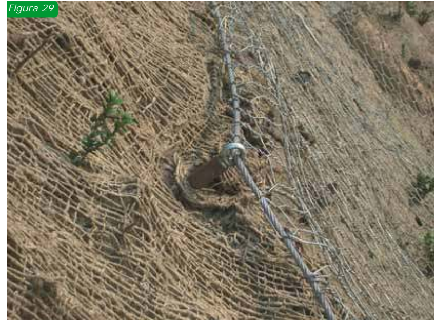
Fig.29: particolare del fissaggio al suolo di reti e sviluppo di una talea a chiodo
