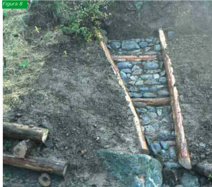
Figg.6-7-8: fasi costruttive di un breve tratto di canalizzazione in legname e pietrame, per favorire il corretto scarico delle acque in un torrente
