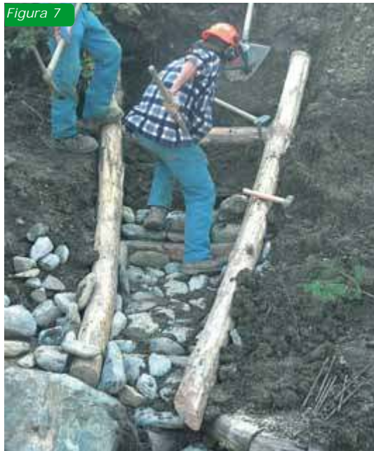
Figg.6-7-8: fasi costruttive di un breve tratto di canalizzazione in legname e pietrame, per favorire il corretto scarico delle acque in un torrente
