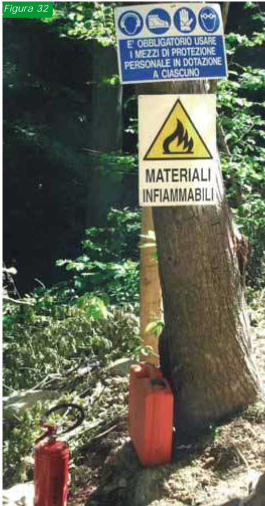
Fig.32: in cantiere deve essere disponibile e pronta all'uso la dotazione antincendio e di pronto soccorso
