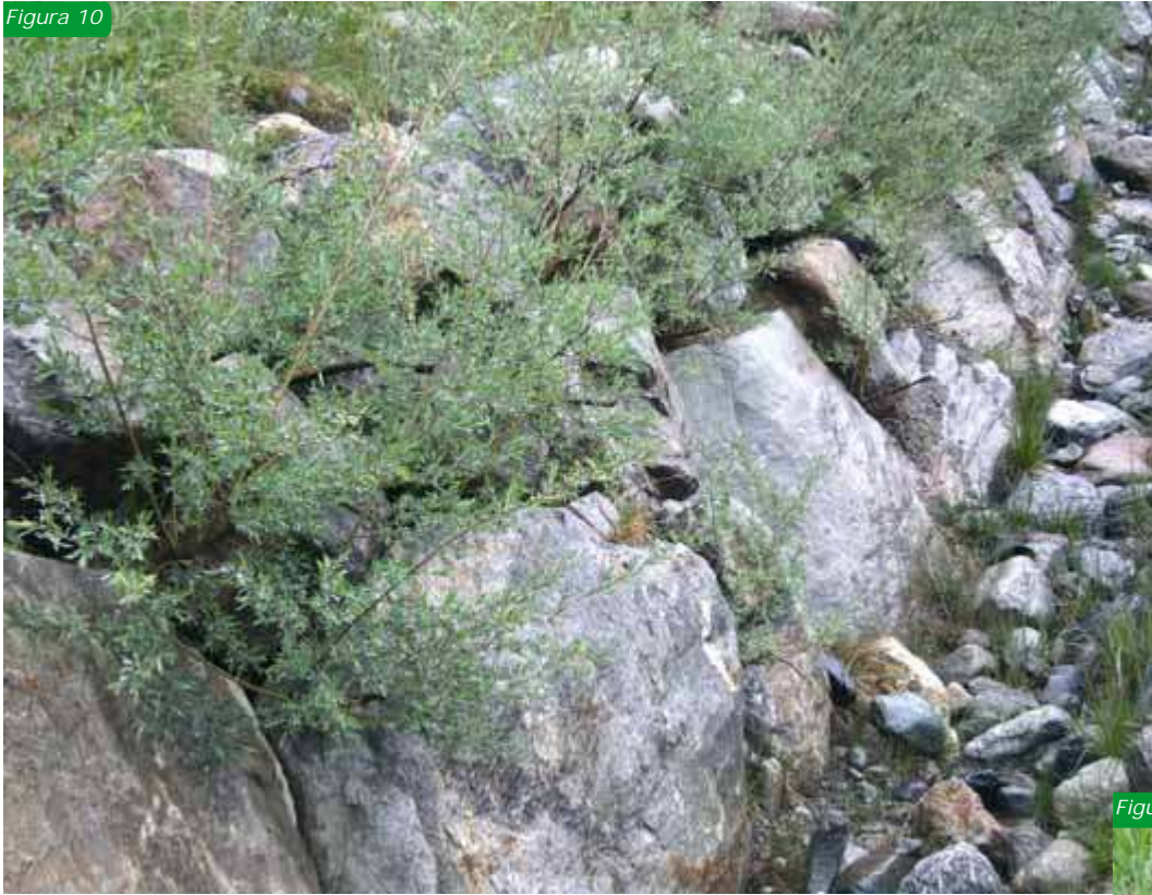
Figg.10-11:scogliere rivegetate con l'impiego di talee di Salix spp.
