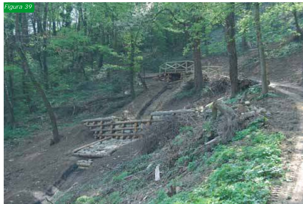
Figg.37-38-39: costruzione di una briglia con platea di dissipazione in massi e legname, poste a valle del salto
