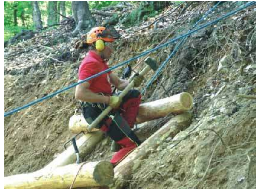
Fissaggio delle travi ai montanti mediante chiodatura
