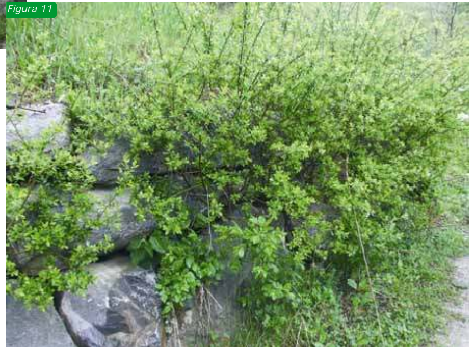
Figg.10-11:scogliere rivegetate con l'impiego di talee di Salix spp.
