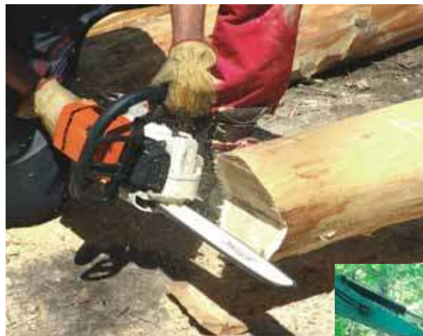
Preparazione della base dei montanti
