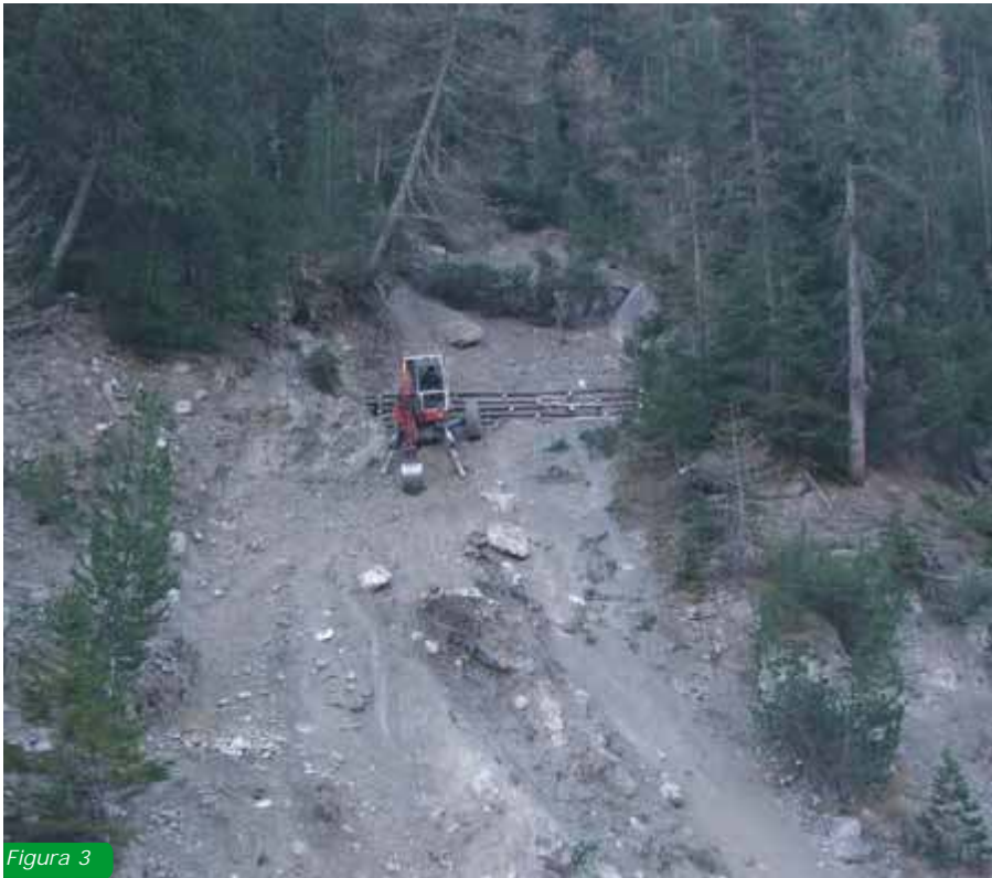
Fig.3: ragno meccanico impegnato in lavori di scavo su versanti ibridi
