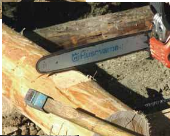
PER L'APPOGGIO, VIENE LAVORATA LA FACCIA INFERIORE DEL TRAVERSO!
