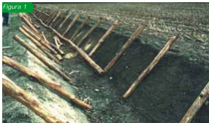
Figg.1-2-3: fasi costruttive di una canalizzazione in legname e pietrame
