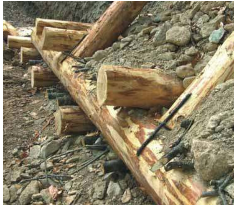
Fissaggio delle travi ai montanti mediante chiodatura
