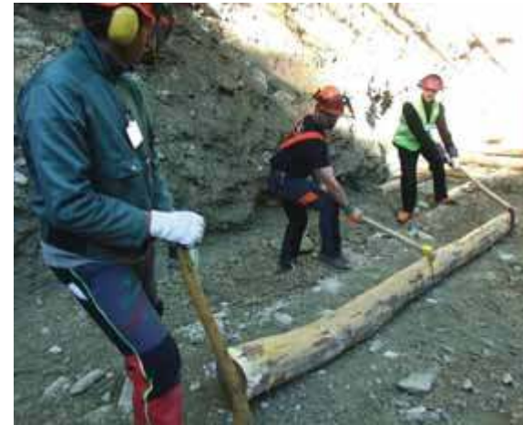
POSIZIONAMENTO E GIUNZIONE TRA CORRENTI DI BASE
