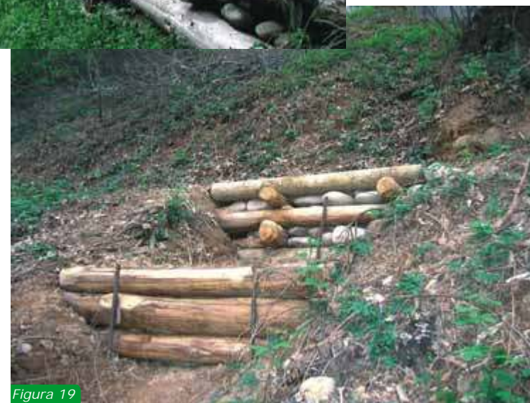
Figg. 18-19: cunei filtranti in legname e pietra messi a sostegno e drenaggio di viabilità minore
