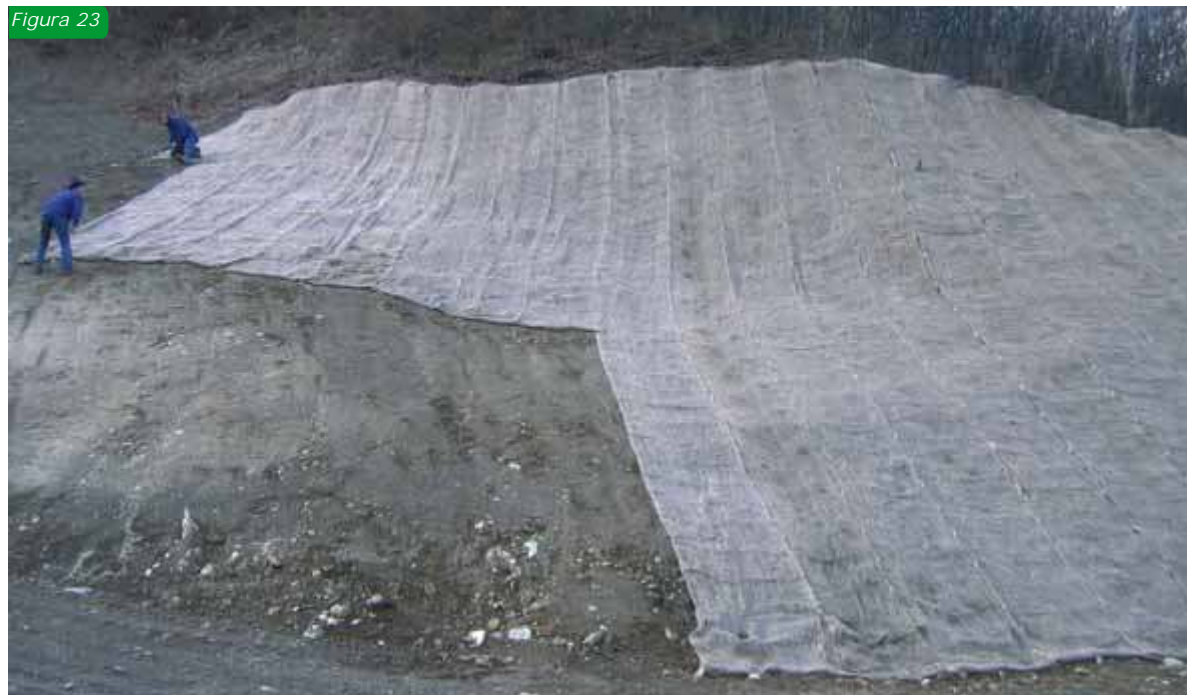
Fig.23: posa di rete in fibra naturale di juta
