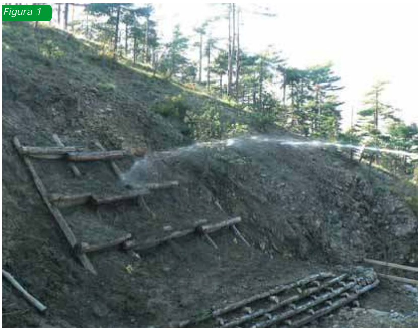
Fig. 1-2: inerbimento mediante idrosemina
