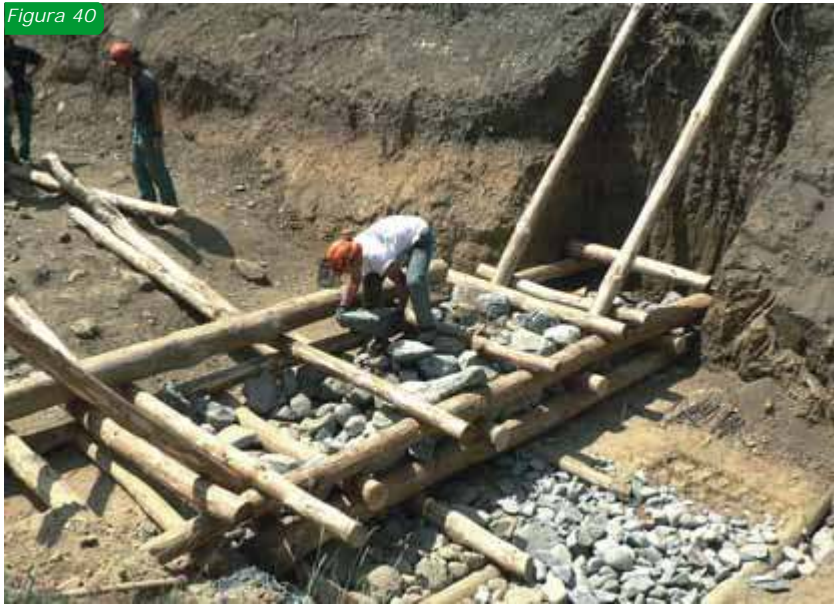
Figg.40-41-42-43: fasi costruttive di una briglia con ali molto pronunciate
