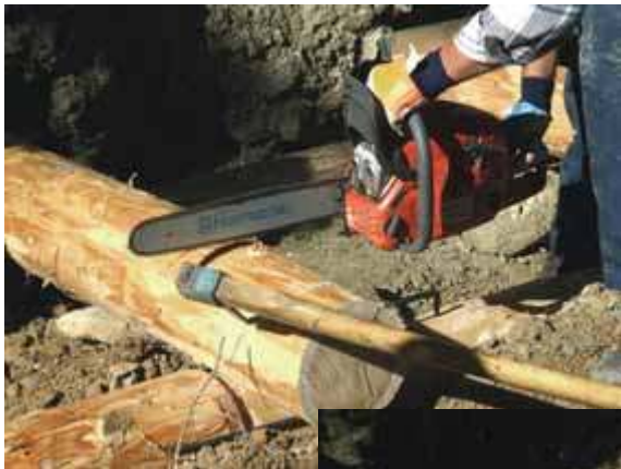
PREPARAZIONE E GIUNZIONE DI TRAVERSI SUI CORRENTI, INTESTATURA DEI TRONCHI
