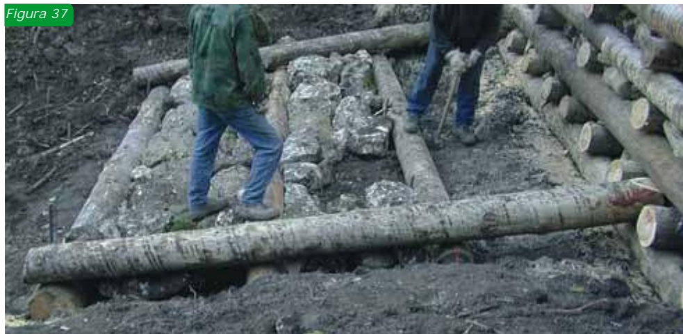
Figg.37-38-39: costruzione di una briglia con platea di dissipazione in massi e legname, poste a valle del salto
