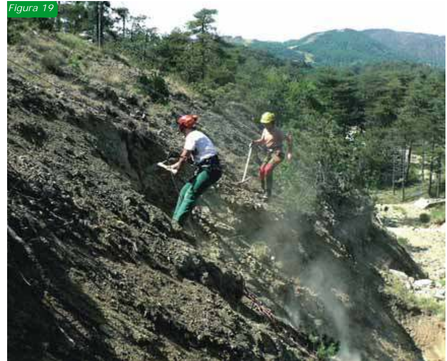
Fig. 19: disgaggio manuale di masse rocciose e terreno instabile
