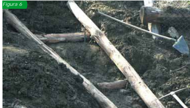
Figg.6-7-8: fasi costruttive di un breve tratto di canalizzazione in legname e pietrame, per favorire il corretto scarico delle acque in un torrente
