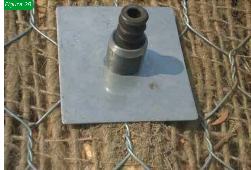
Fig.28: ancoraggio al suolo di rete in fibra naturale e rete metallica, con impiego di barre filettate
